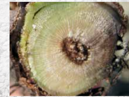
Daño por Eutipiosis (Foto: Dpto. San. Veg. Cádiz)
